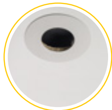
4. Durch den Reduzierring haben Sie den vergrößerten Deckenausschnitt gänzlich abgedeckt.
